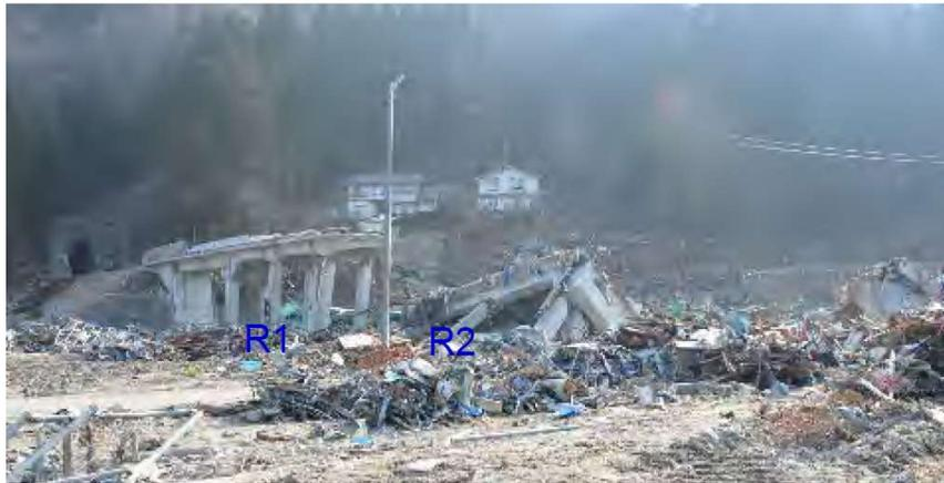
三陸鉄道の島越駅とそれに隣接するRCラーメン構造の高架橋も、津波によって完全に崩壊しました。
