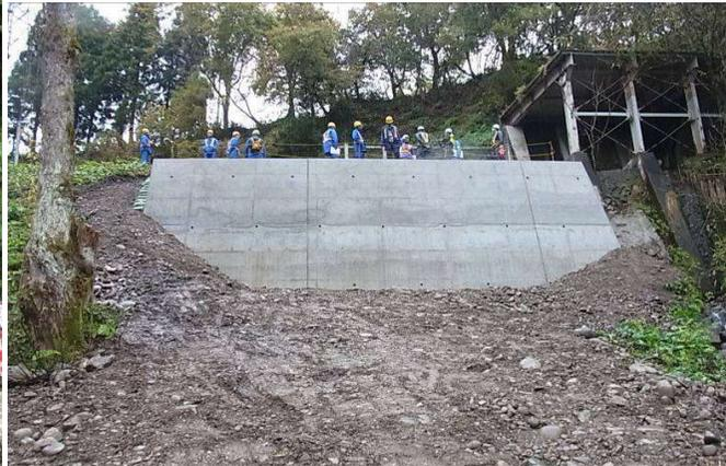
GRS擁壁による強化復旧(越後鹿渡方より) コンクリート壁面工の施工線路右側より)
