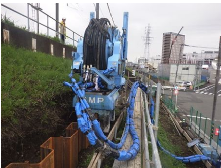
写真-2 仮設土留壁施工状況
