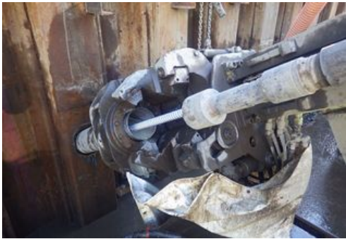
写真-8 芯材押し込み状況
