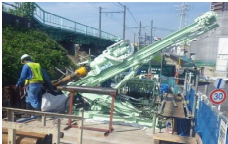
写真-3 キャロットアンカー施工状況(スキッド型)
