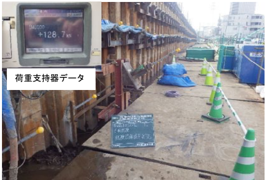
写真-9 確認引き抜き試験状況
