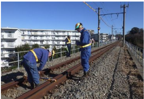
写真-4 軌道変位測定状況
