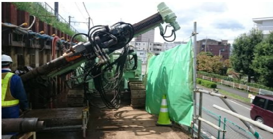
写真-5 キャロットアンカー施工状況(クローラー型)
