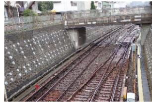
写真 5.2 補強工事後
