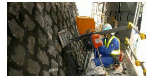
写真 4.1 コアドリルによる削孔
