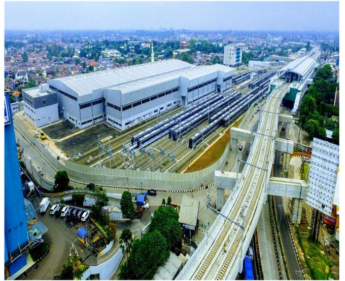
写真-12 Jakarta MRT Project の車両基地建設工事に採用された「RRR-GRS擁壁」（写真提供：東急建設（株））
