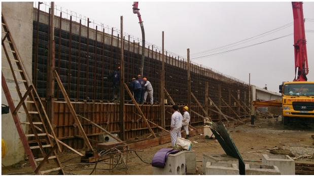
写真-11 ベトナムにおける「RRR-GRS擁壁」の施工状況（写真提供：大成建設（株））
